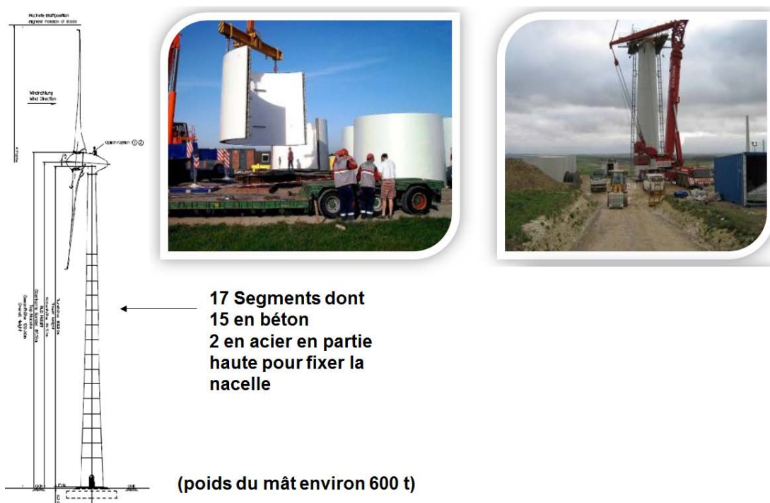
Installation des segments béton d'un mât d'une éolienne Enercon
