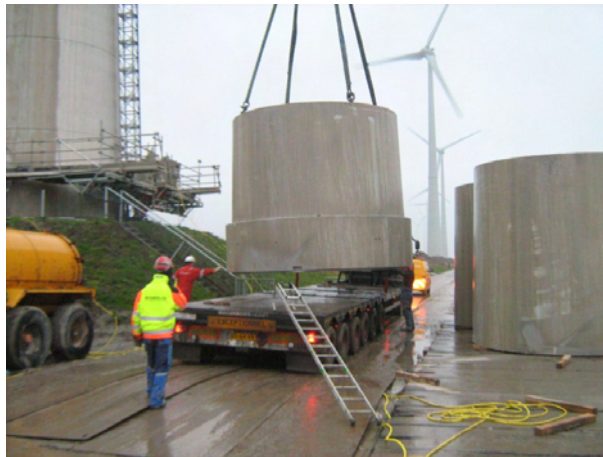
Figure 15: Enlèvement pour réutilisation
