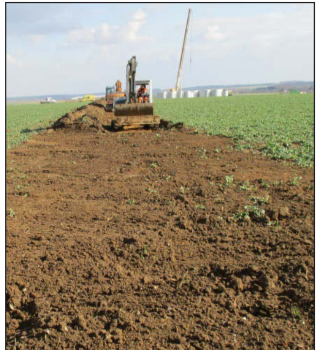
Rebouchage de la tranchée sur parcelle agricole
