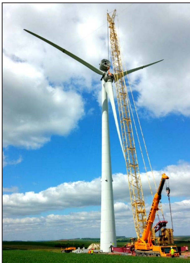
Levage du rotor
