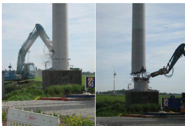
Figure 8: Excavateur de démolition en action sur une petite éolienne (pendant les travaux de démontage le mât est retenu par une grue)
