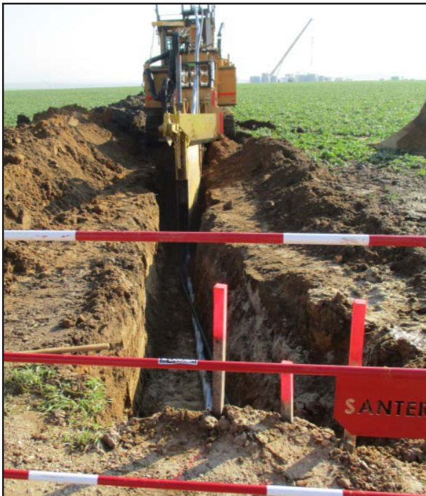
Réalisation d'une tranchée dans une parcelle
