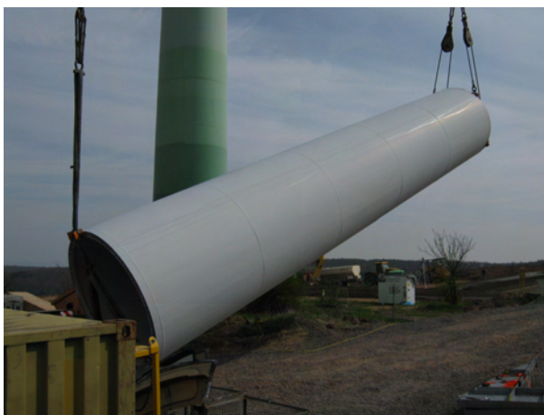
Figure 16: Déposer la section du mât
