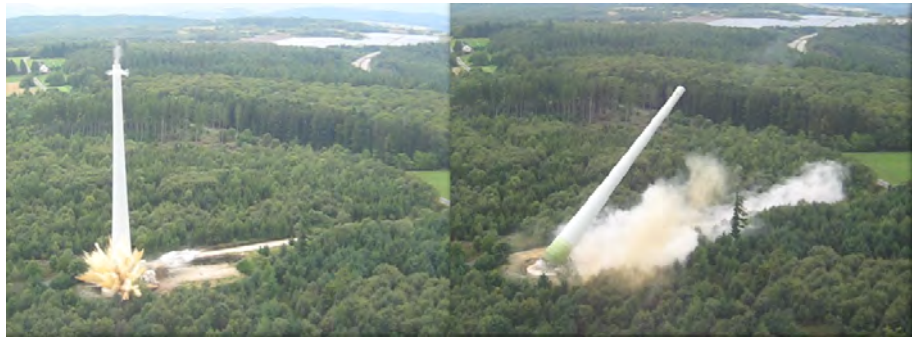
Figure 6: Dynamitage du mât en béton d'une éolienne
